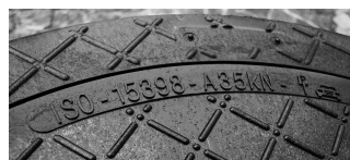
Ansicht Belastungsklasse A35kN auf Deckel
